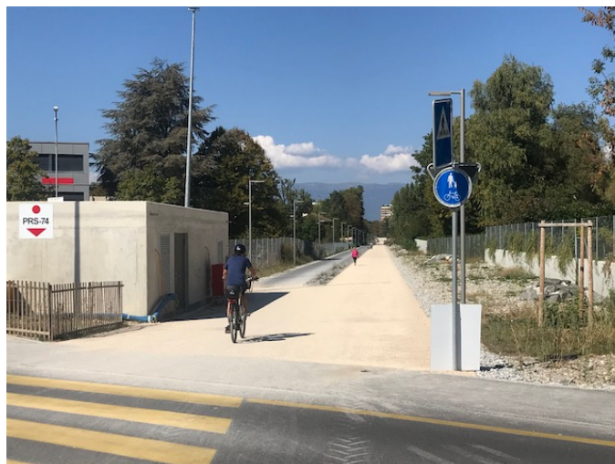
Grange-Falquet – Voie verte
