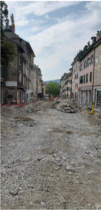
Photo après la démolition de la structure du tram
