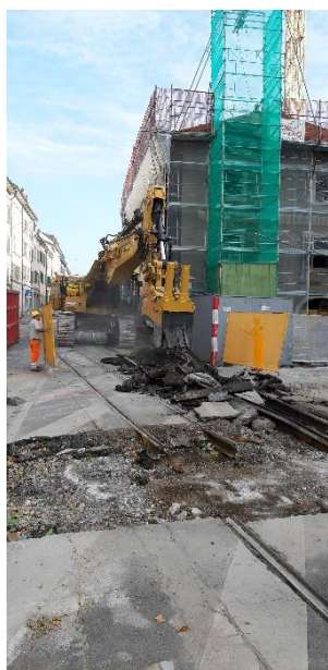
Arrachage et découpage des rails du tram
