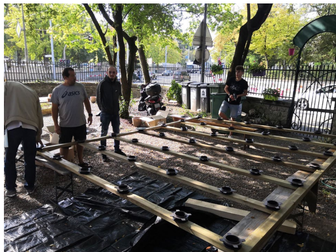
Chantier éducatif – création d'une terrasse en bois au 2, chemin De-La-Montagne
