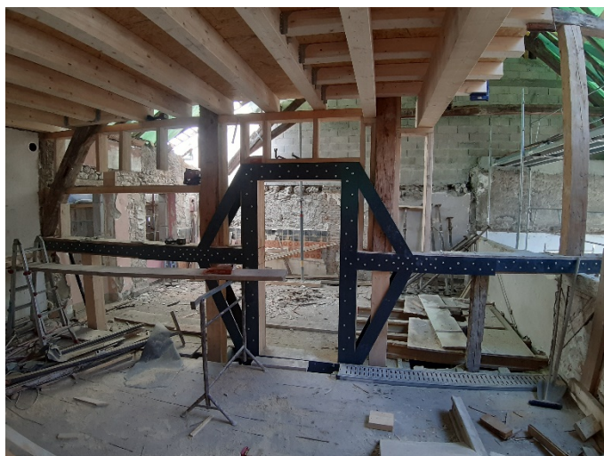
Création d'une porte pour les futures chambres d'étudiant – rue de Chêne-Bougeries 25
