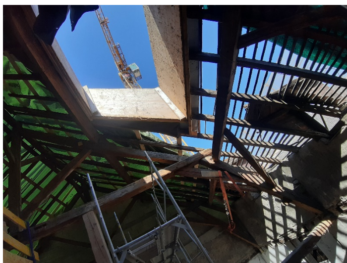
Ouverture d'une trémie – rue de Chêne-Bougeries 27
